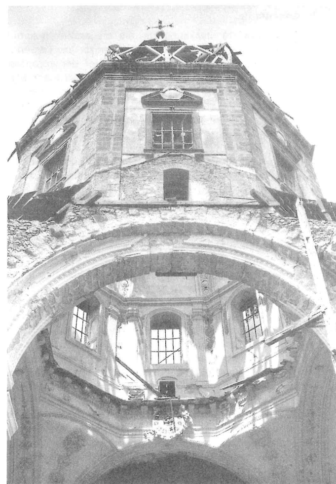
Abb. 2. Innsbruck, Jesuitenkirche, Blick in die Kuppellaterne nach der Bombardierung
